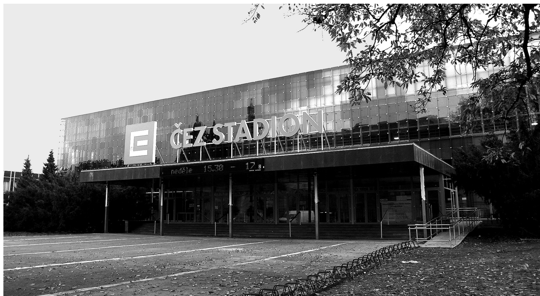
HRADECKÝ ČEZ STADION prochází již druhým rokem rozsáhlou rekonstrukcí. V letošním roce se dočkal zcela nového opláštění, které připomíná podobu ledové kostky. Foto: www.hchk.cz
